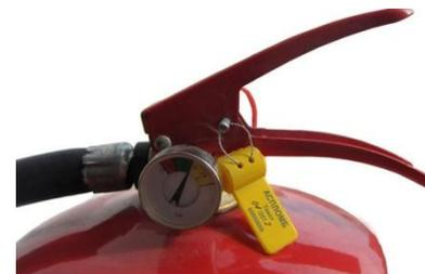
Перед введением огнетушителя в эксплуатацию он должен быть подвергнут первоначальной проверке, в процессе которой производят внешний осмотр, проверяют комплектацию огнетушителя и состояние места его установки (заметность огнетушителя или указателя места его установки, возможность свободного подхода к нему), а также читаемость и доходчивость инструкции по работе с огнетушителем.
